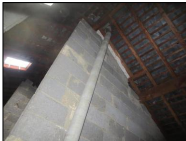
Photo N° 883 AMIANTE CIMENT -- COMBLES Gaines & coffres verticaux Ventilation haute (Fibres- ciment)
